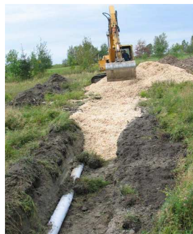
Photo 4: Réalisation d'une tranchée filtrante
