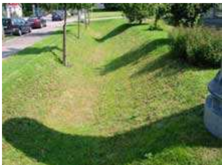
Photo 15: Exemple de noues enherbés
